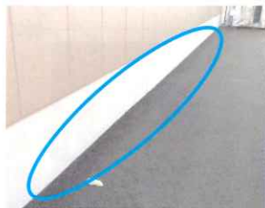
建物と周りの地盤と一緒に沈下しているため、段差が発生していない。
