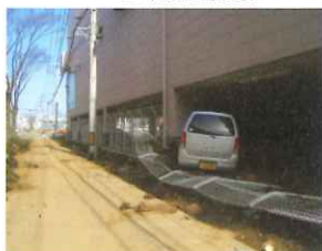
津波の被害を受けるが、外装に目立った損傷はなし。
