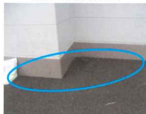
段差やひび割れ等は発生していない。
